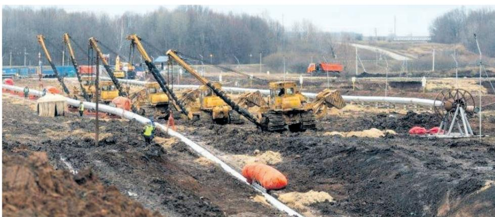
Реализован проект по капитальному ремонту резервной нитки подводного перехода магистрального этанопровода Миннибаево – Казань DN 500 через реку Каму
