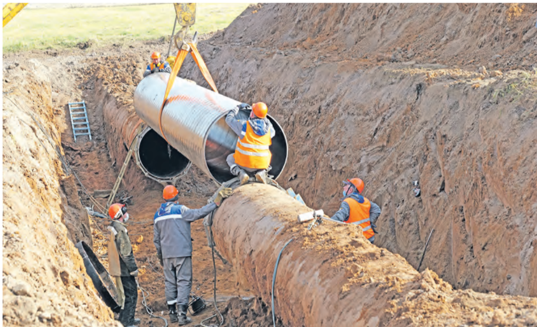
Устранение дефектов по результатам внутритрубной диагностики на участке 2199–2229 км МГ Ямбург – Елец 2 DN 1400
