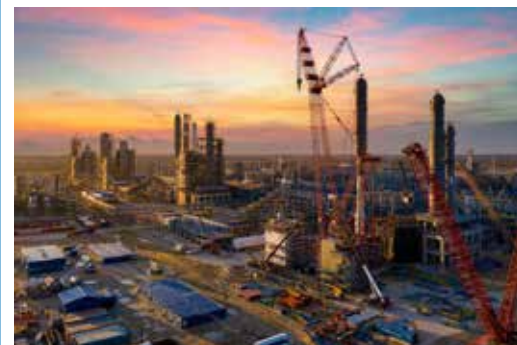
Строительная площадка Амурского газоперерабатывающего завода
