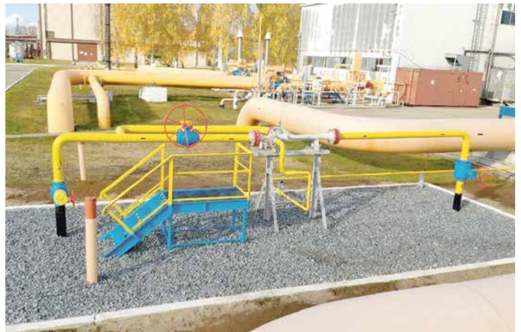
Эжектор откачки газа из оборудования компрессорных станций в технологической обвязке на КС «Арская»
