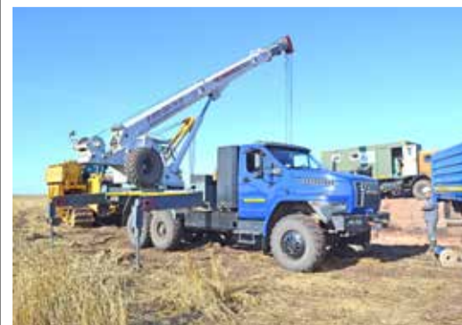
В капитальном ремонте газопроводов задействовано много спецтехники
