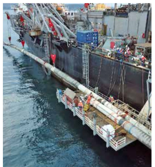
Соединение морской и наземной частей газопровода «Турецкий поток»
