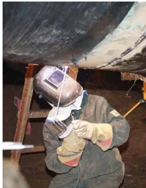
Ремонт участка газопровода
