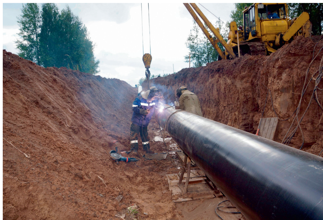
Капитальный ремонт магистрального газопровода «Миннибаево-Казань»
