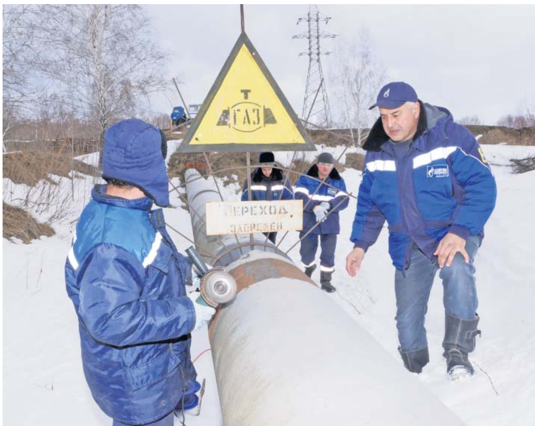
Проводится диагностика старейшего газопровода Татарстана Миннибаево – Казань, запущенного в эксплуатацию в 1954 году
