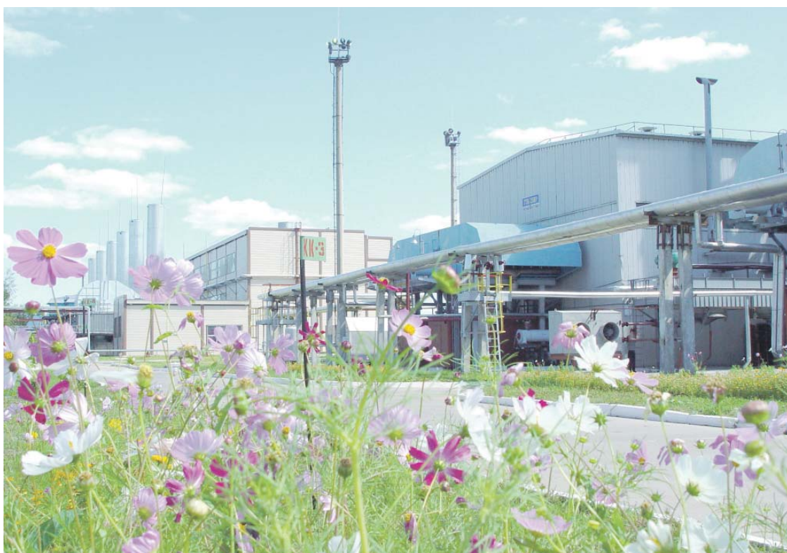
Так выглядит компрессорная станция «Арская» Шеморданского линейно-производственного управления магистральных газопроводов
