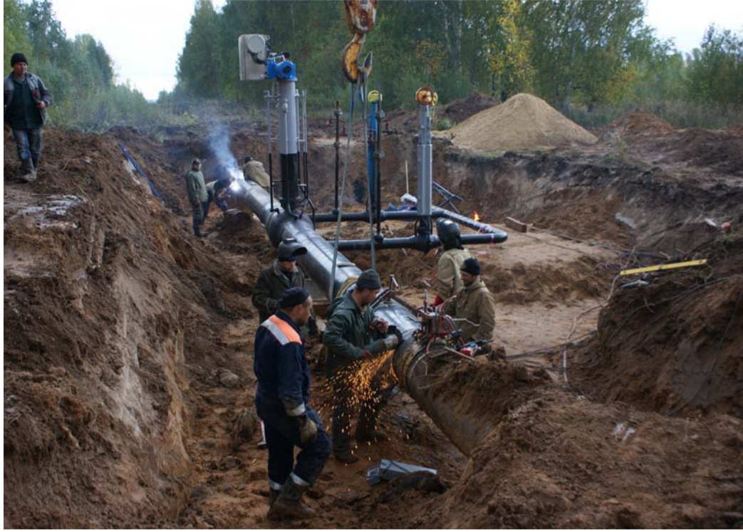
Летом текущего года газовики начали капитальный ремонт двух линейных участков газопроводов Казань – Нижний Новгород и Миннибаево – Ижевск
