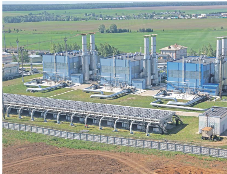
Активные магнитные подшипники в центробежных компрессорах сегодня применяются практически на всех компрессорных станциях Газпрома, в том числе на одной из крупнейших в его системе — «Арской»
