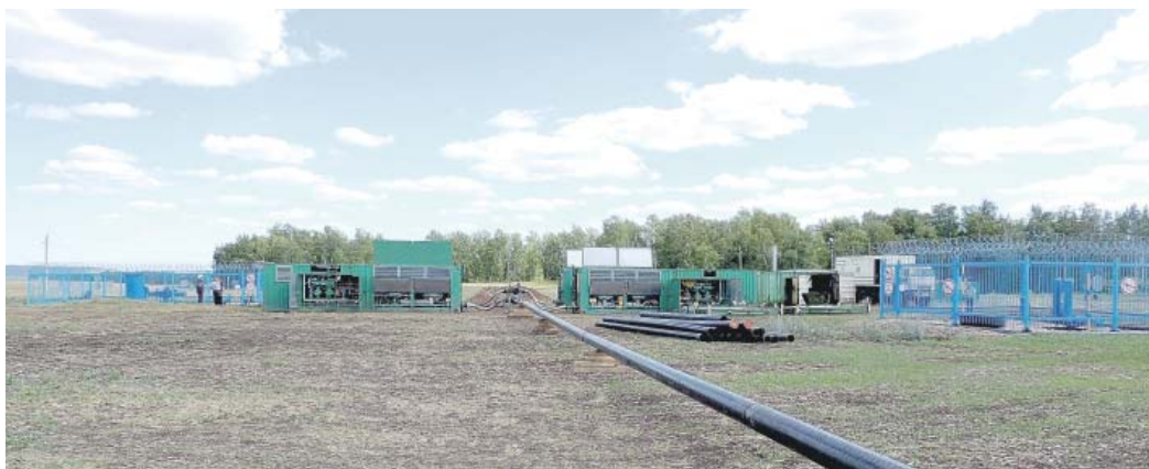
Специалистами Альметьевского ЛПУМГ и ООО «БашУралМонолит» впервые в Обществе «Газпром трансгаз Казань» была произведена перекачка газа из ремонтируемого участка газопровода в действующую магистраль с помощью мобильной компрессорной станции.
