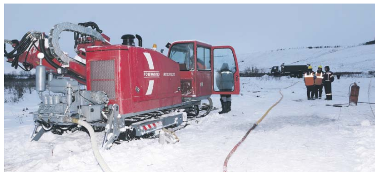
При помощи установки FORWARD было проведено горизонтальное направленное бурение скважины на реке Меша
