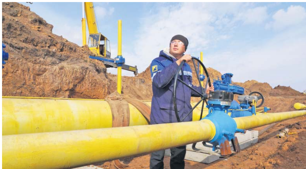
За «штурвалом» газовой трубы.
